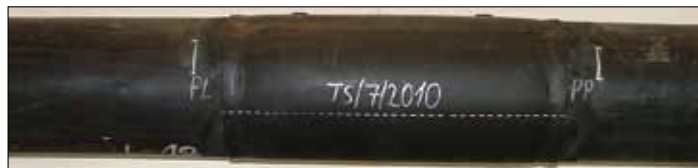
Fot. 3. Złącze z mufą otwartą zgrzewaną elektrycznie
