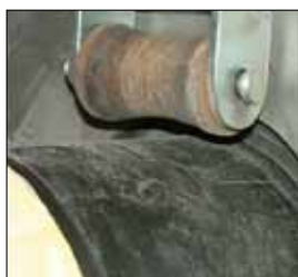
Fot. 12. Położenie początkowe rury w otworze skrzyni. Płaszcz osłonowy w pewnej odległości od rolki oporowej
